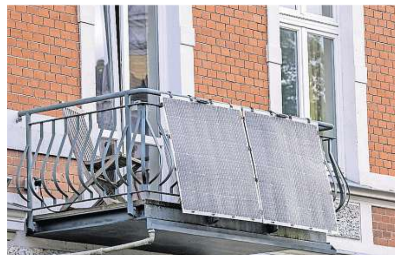
Solarmodule für ein sogenanntes Balkonkraftwerk am Balkon eines Hauses (Symbolfoto). Königswinterer haben jetzt die Möglichkeit, Fördermittel für Stecker-Solargeräte zu erhalten.
